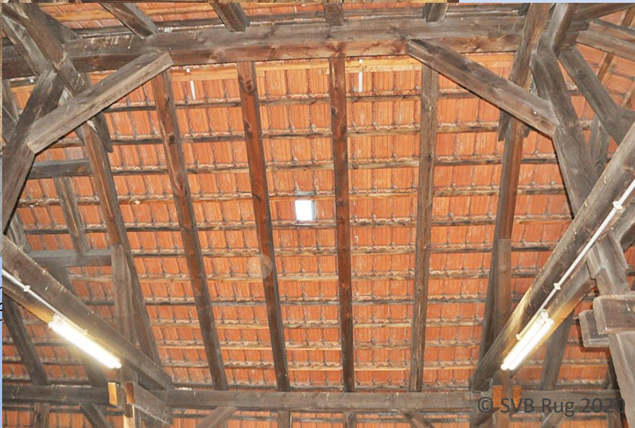
Dachkonstruktion einer ehem. Militärakademie (Baujahr: 1904/05)
