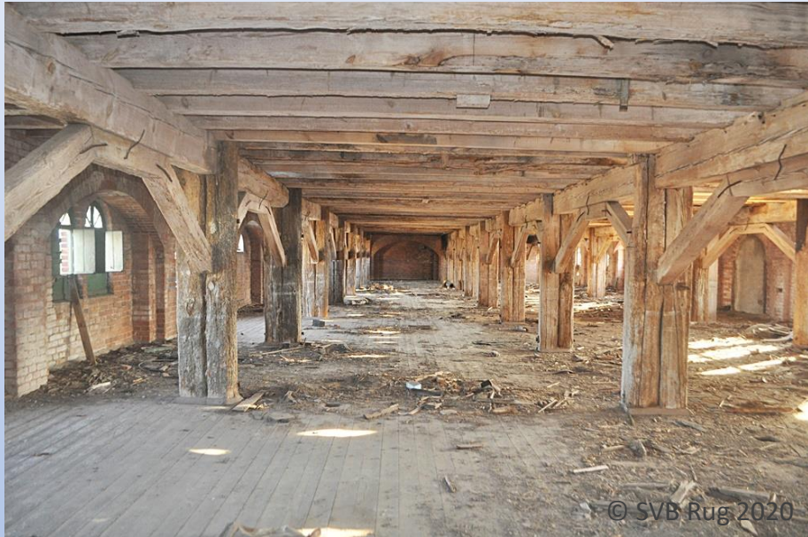
Deckenkonstruktion eines Speichergebäudes (Baujahr: 1856)
